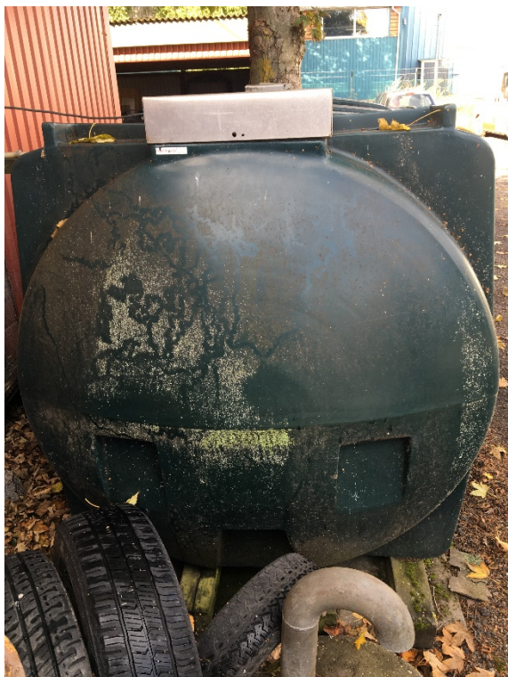
Foto 14: Plastolietank uden mærkat, oplyst fra 2005.
