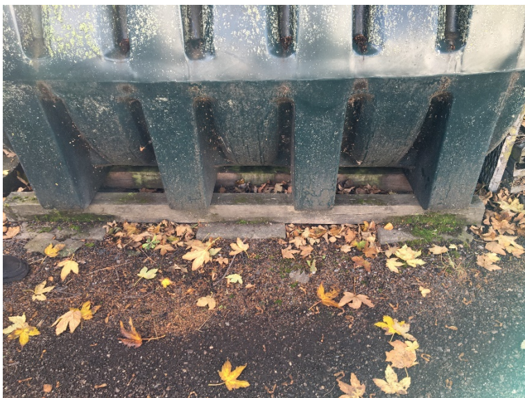
Foto 15: Fliser og lægter under olietank.
