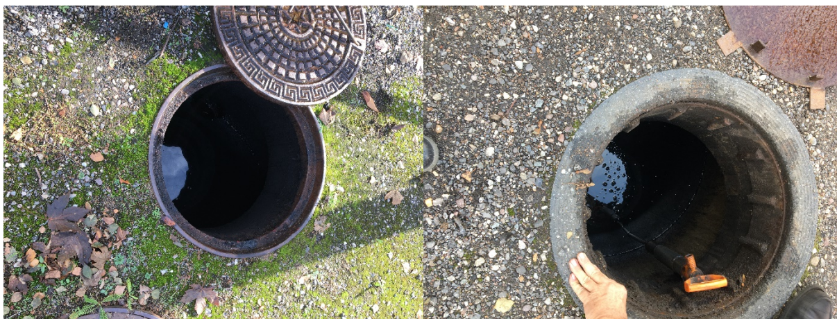
Foto 17: Anordning på første olieudskillere som anvendes til pejlinger.
